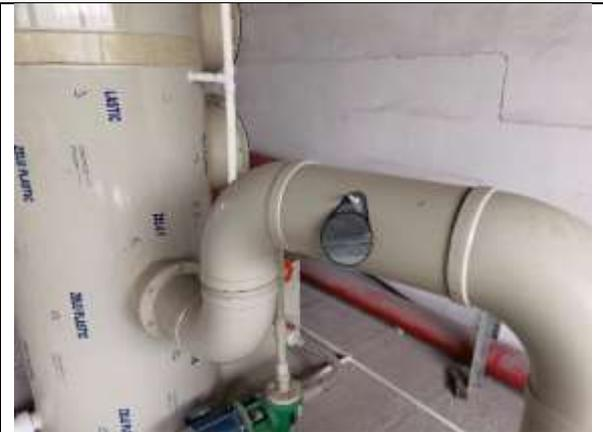
酸性废气处理设施进口采样口
