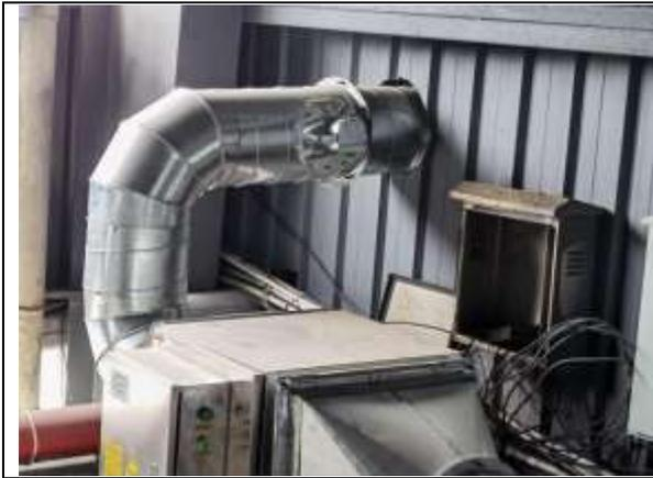
油罐区废气静电除油处理设施及进口采样口
